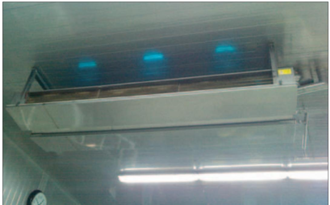
Abb. 17: Beidseitig ausblasender Hygieneluftkühler mit innen liegenden UVC-Modulen
