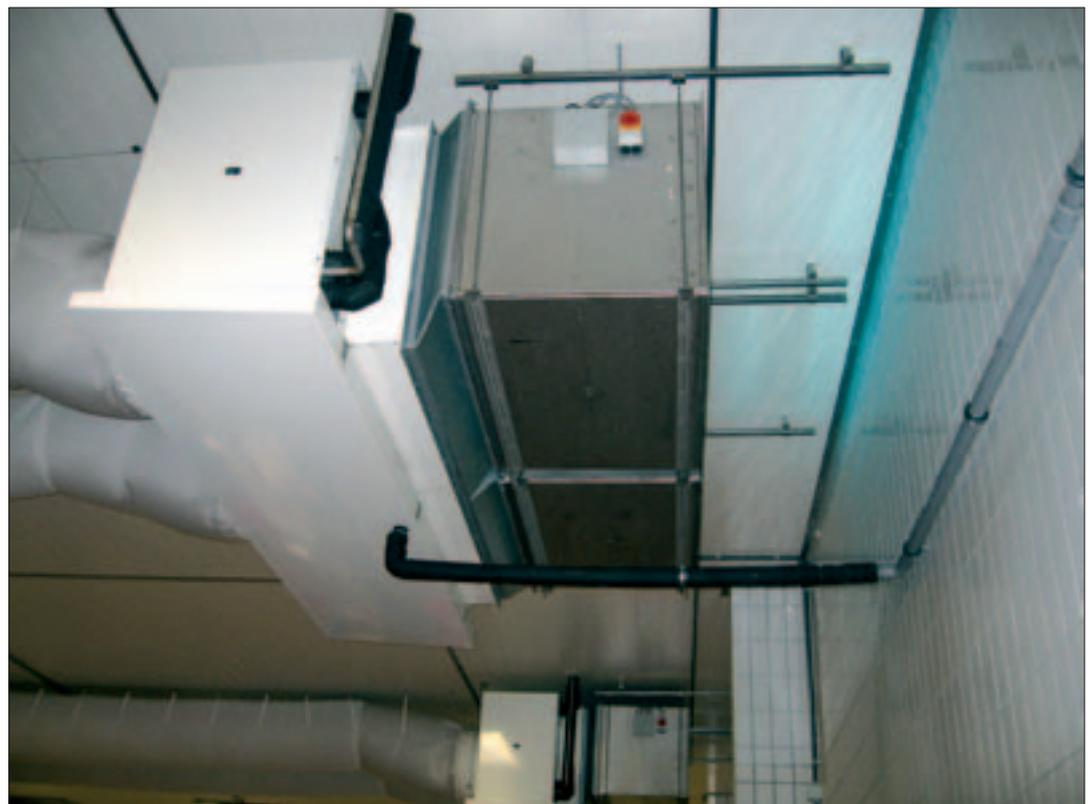
Abb. 18: Eine optimale Anordnung und Auslegung am Einlassbereich eines Luftkühlers. Die Edelstahl UV-Kammer entkeimt die Produktionsluft und sorgt für hygienische Kühlrippen auf der Ansaugseite.
