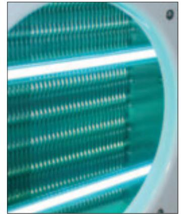
Zwei Verfahren ein Ziel: Abb. 11 (links): Die Vorbaumodule vom Typ LKV werden vor den Ansaugbereich der Luftkühler montiert. Abb. 12 (rechts): Bei drückenden Luftkühlern erfolgt der Einbau mit EFD Systemen innerhalb des Luftkühlers.
