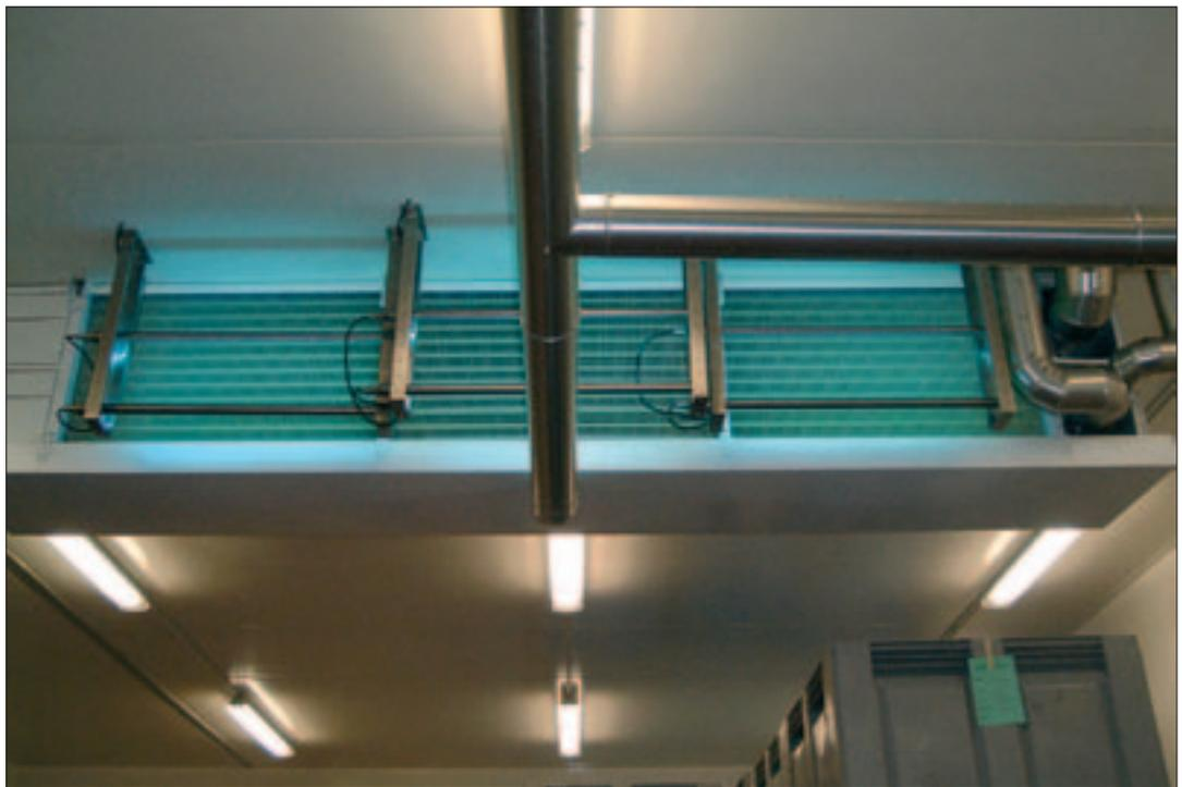
Abb. 16: Auf der Ansaugseite vor die Luftkühler montierte LKV-Module bestrahlen die Kühl lamellen und verhindern die Ablagerung und das Wachstum von Mikroorganismen.
