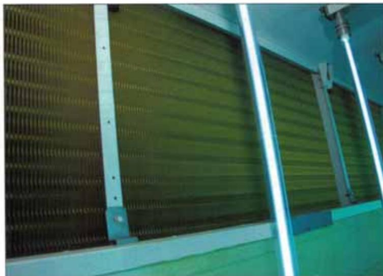
*Abb. 8: Durch Oberflächenbestrahlung im Ansaugbereich von Luftkühlern bleiben die Kühlrippen frei von mikrobiellen Ablagerungen. Einer Verschlechterung der Luftkühlerhygiene zwischen den gesetzlich vorgeschriebenen Reinigungszyklen wird vorgebeugt.*
